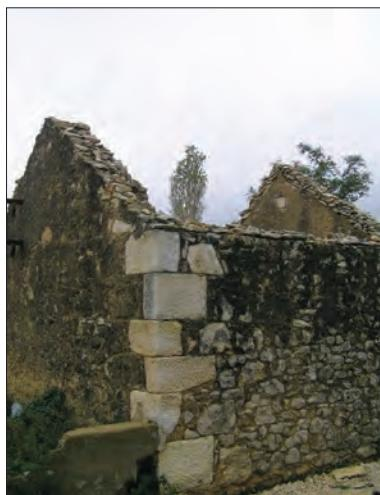
Gradnja zida počinjala je postavljanjem kantuna na čoškove (Grm34) (Sl.11). Potom se naizmjence slagalo veće i manje kamenje (Kž28) te škalj (sitni kamen) (Kž35). (...) metneš kamen pa metneš te malte, onda drugi kamen da prione jedno uza drugo onda iznutra
